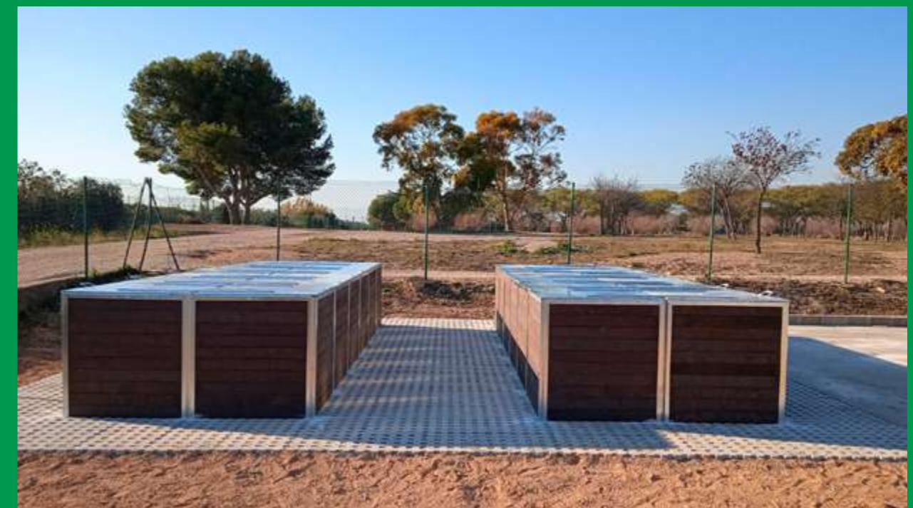
Centro de compostaje comunitario en el municipio de Vila-seca.
